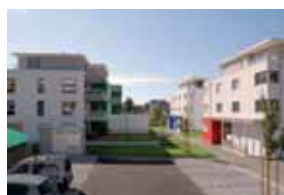
⑮ Lengnau, Ambiente 17 appartements de propriétaires. Standard bonacasa® Standard MINERGIE®
