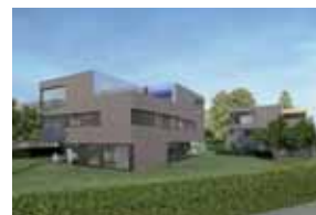
⑫ Feldbrunnen, casa meridiana 9 appartements de propriétaires/6 maisons jumelées, Standard bonacasa® Standard MINERGIE®
